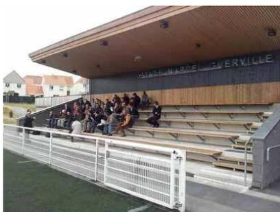
Après l'aventure réussie de la rénovation de la salle Grémaux de Lezennes (59) qui a utilisé 30 m<sup>3</sup> de peuplier en structure, pas moins de 180 m<sup>3</sup> ont été nécessaires à la construction de l'auvent et de l'ossature des vestiaires du stade Guerville à Etaples sur Mer (62).
