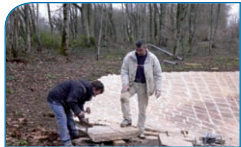
Travaux de restauration de l'étanchéité d'une mare pavée.
