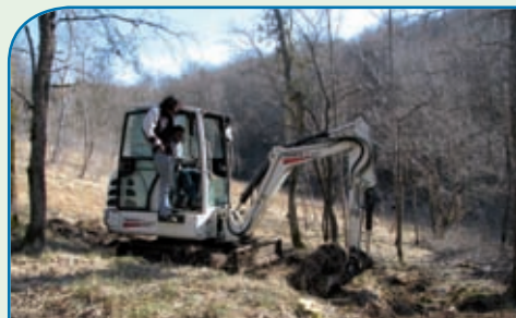
Restauration du fonctionnement hydraulique dans le marais.
